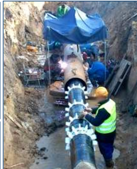
Krycí plechy konce chráničky a podélných spojů chráničky
