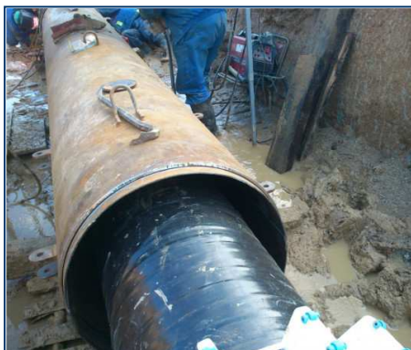
Krycí plechy konce chráničky a podélných spojů chráničky
