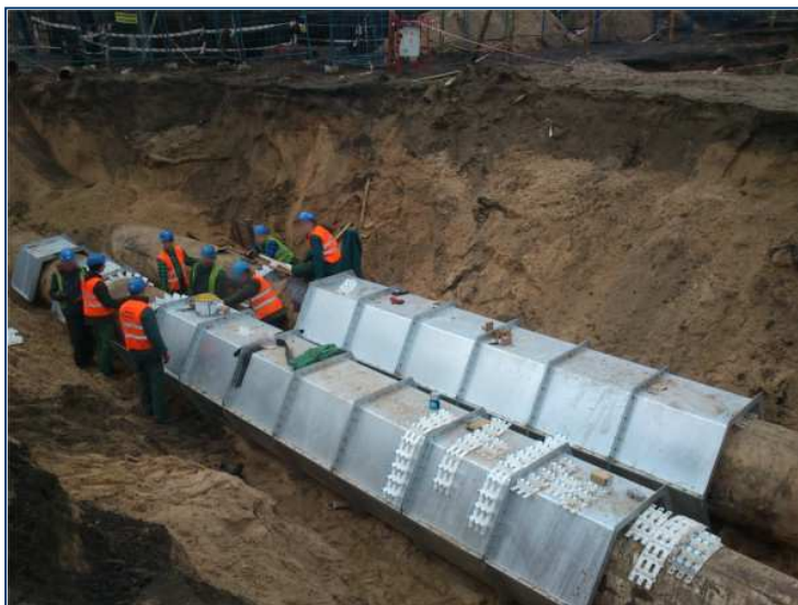
Prodloužení chráničky z trubky pomocí speciálního spojovacího kusu (např. při rozšíření silnice)
