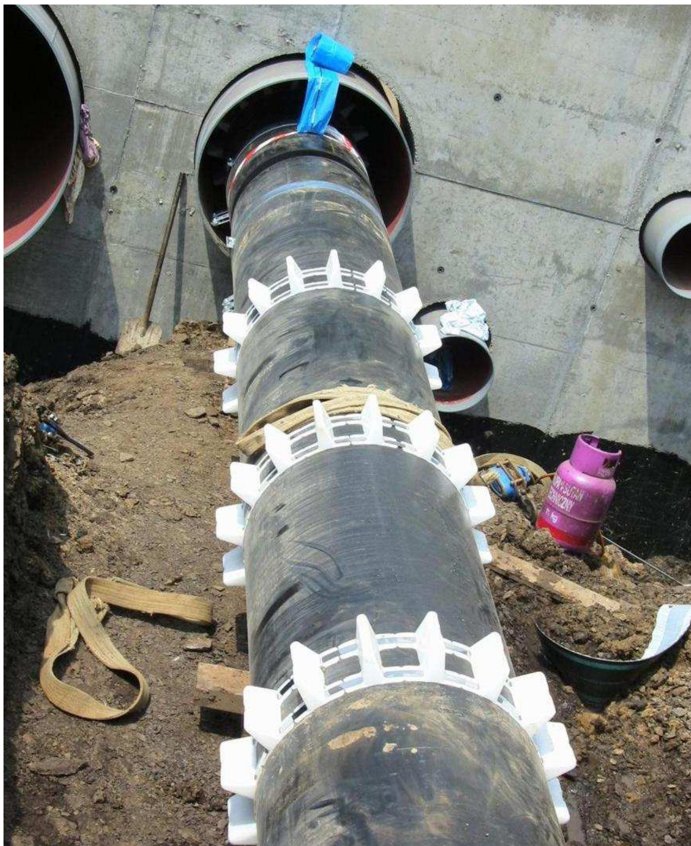
03 Distanční objímky „SM“ - nasunutí potrubí do chráničky
