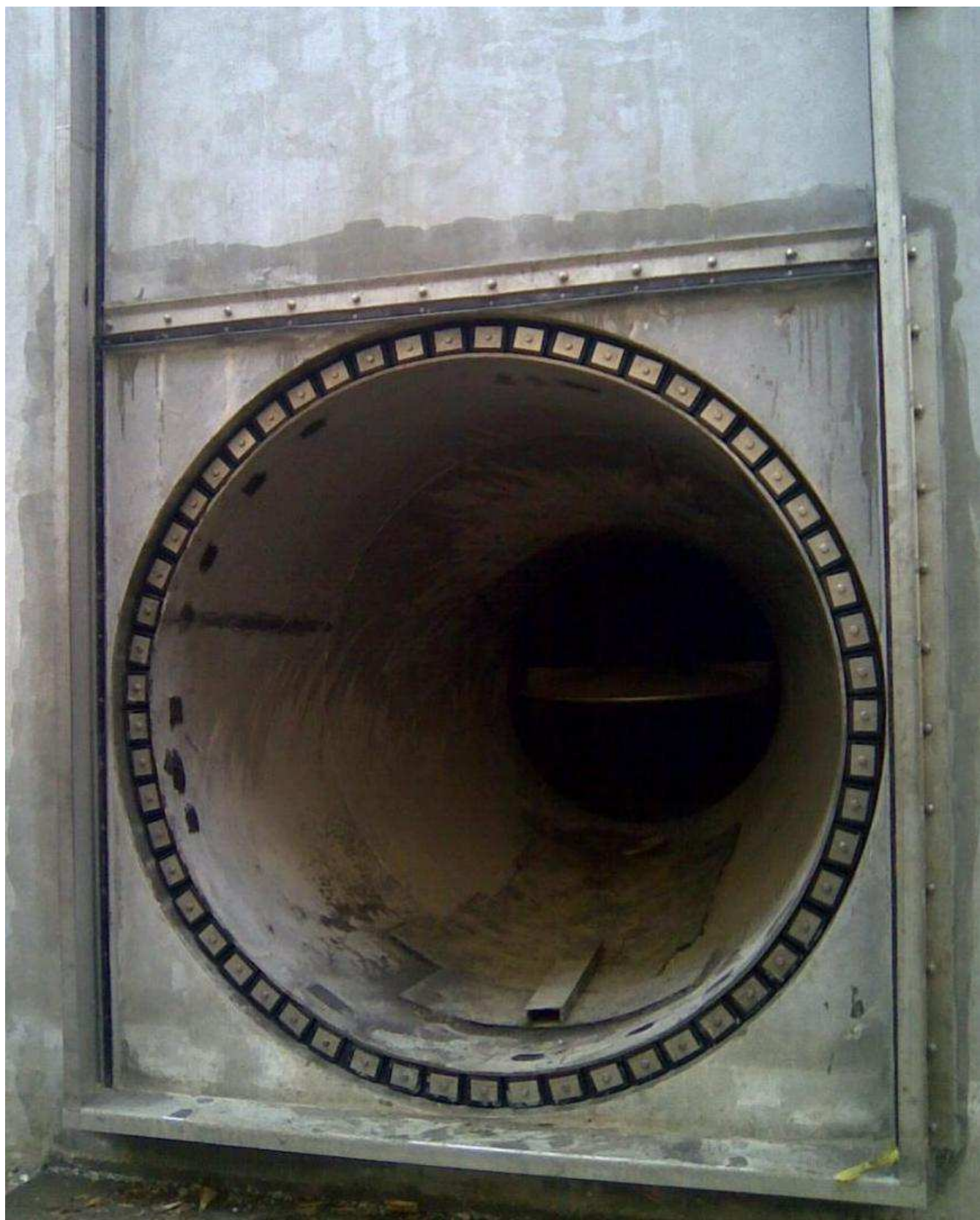
02 Těsnící řetězy typu „LU-...“ - příklad použití pro velké průměry
