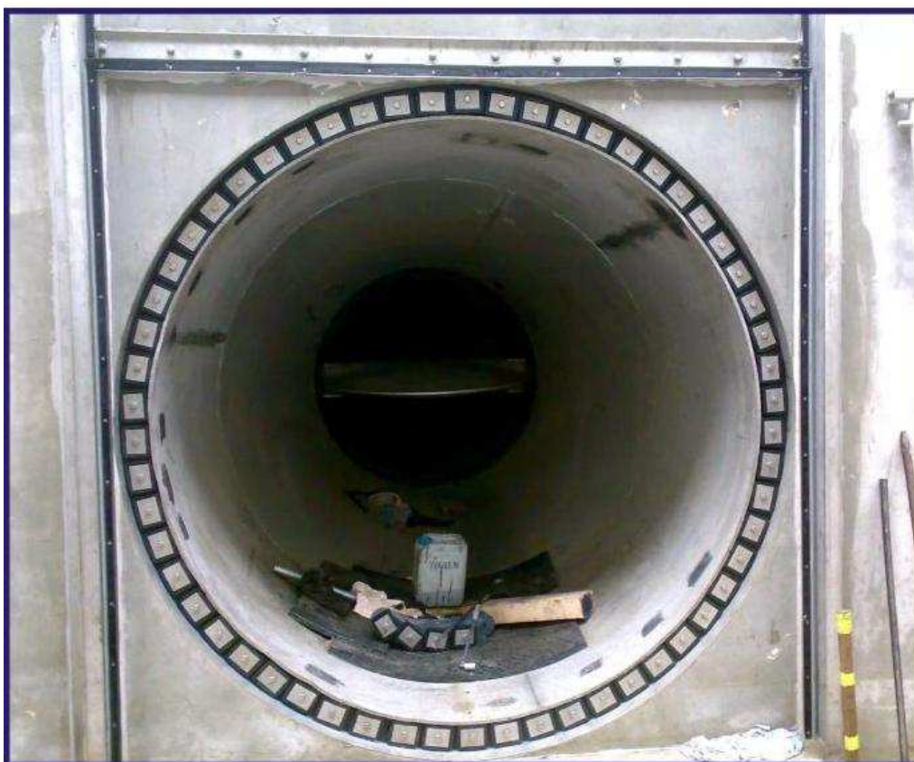
01 Těsnící řetězy typu „LU-...“ - osazení a montáž
